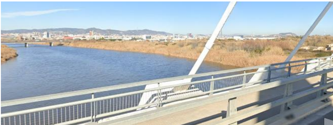
Vista del marge esquerre del riu Llobregat des de pont de Nelson Mandela, al punt on es prolongarà el via ferroviari i s'iniciarà l'autopista.
